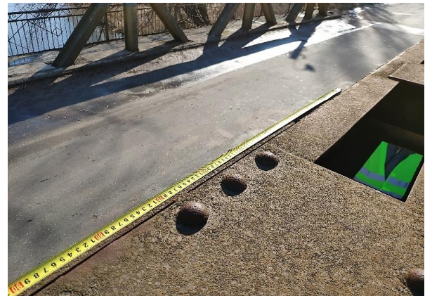
Рисунок 9 — Посилення верхнього поясу в середині прогону листами металу товщиною 3,5 см та довжиною 1,6 м
