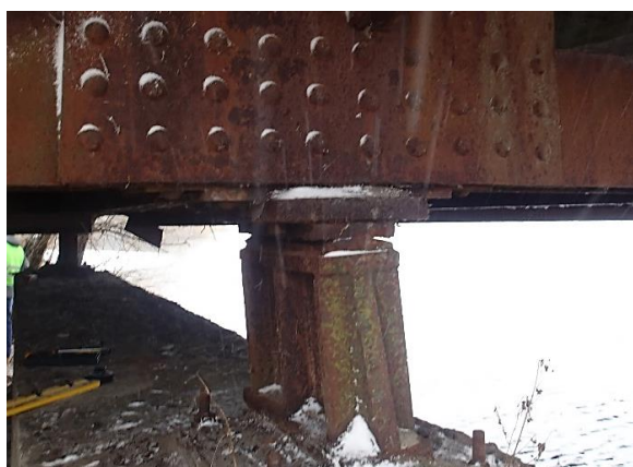
Рисунок 15 — Валкова рухома опорна частина на ОП № 2
