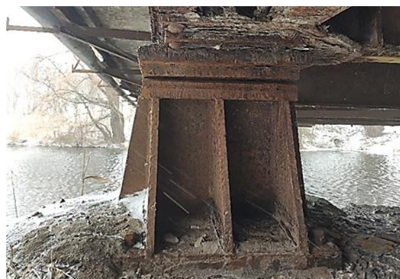
Рисунок 14 — Тангенціальна нерухома опорна частина на ОП № 2
