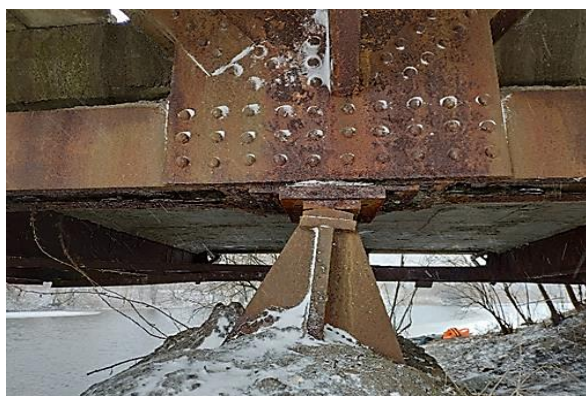
Рисунок 14 — Тангенціальна нерухома опорна частина на ОП № 2
