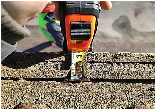
Рисунок 9 — Посилення верхнього поясу в середині прогону листами металу товщиною 3,5 см та довжиною 1,6 м
