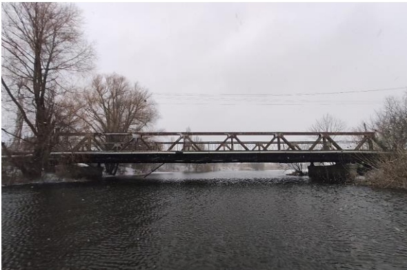
Рисунок 3 — Загальний вигляд мосту з верхової сторони
