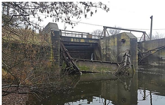
Рисунок 16 — Гідротехнічна регуляційна споруда в 2 км поверху течії (по вул. Благовещенська)
